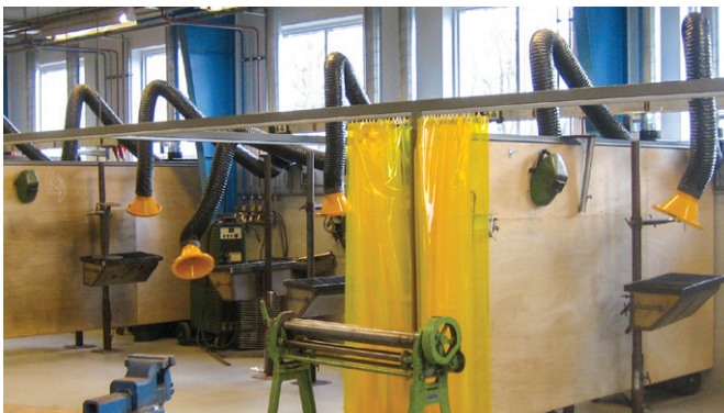
Wing Arme ø160 mm 3 m installiert an einer Fachschule. Einschließlich Automatik für automatisch Start/Stopp des Lüfters und Motorklappe Klappe anbieten.
